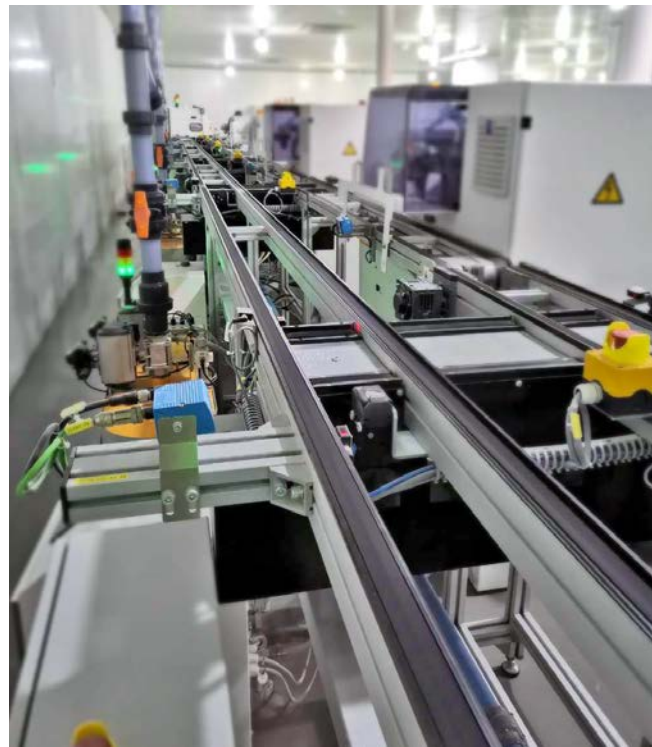
Sistema de control del transportador de pallets
