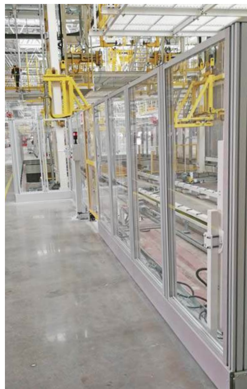
Guarda de Protección para Maquinaria
